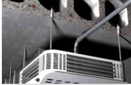
Havalandırma / klima üniteleri
