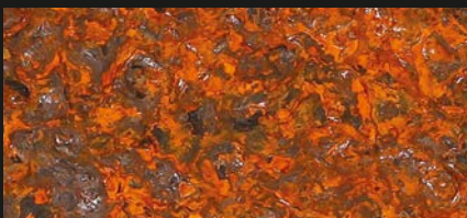
Korozyon koruması işlemi olmadan
